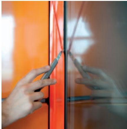
Zorg voor een goede snijtechniek. Raamrubbers mogen vanwege kans op lekkage niet worden beschadigd.
