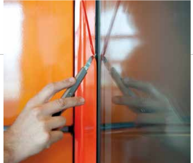
▲ Zorg voor een goede snijtechniek. Raamrubbers mogen vanwege kans op lekkage niet worden beschadigd.
