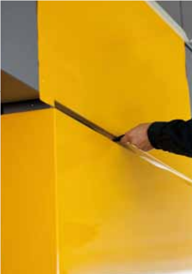
▲ In tegenstelling tot een geschilderde verflaag is de folie overal even dik en dekkend (90 tot 115 micron) dus ook op hoeken.
