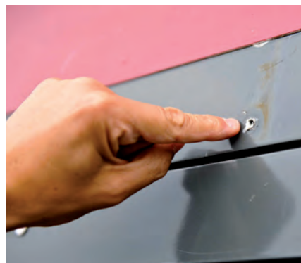
▲ Inventariseer beschadigingen en te verwijderen onderdelen.
