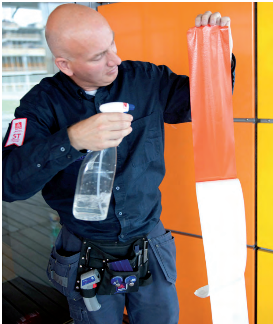
Avery Façade Film is een dunne folie met een extra sterke lijmlaag speciaal voor buildingwrap. Nat aanbrengen, vinden sommige monteurs prettiger.
