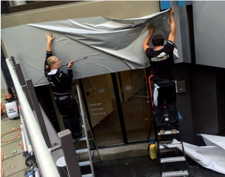
Grote vlakken folie nat monteren, heeft zijn voordelen. Zeker als het waait! Foto: NeroQom Support
