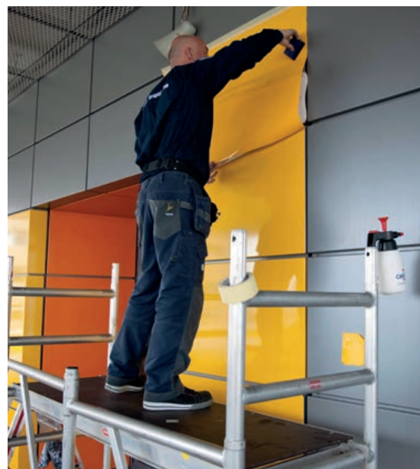
▲ Een groot stuk folie aanbrenge, als deze dun en soepel is, vergt best wel wat techniek. Zeker als de temperaturen stijgen en de folie en lijmlaag bijna 'onhandelbaar' worden.
